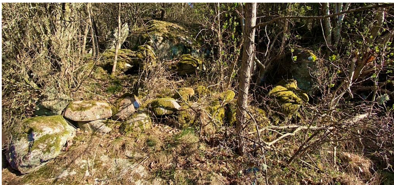
Fig 3. Rester av stenmur i den inventerade sydvända bergskanten
